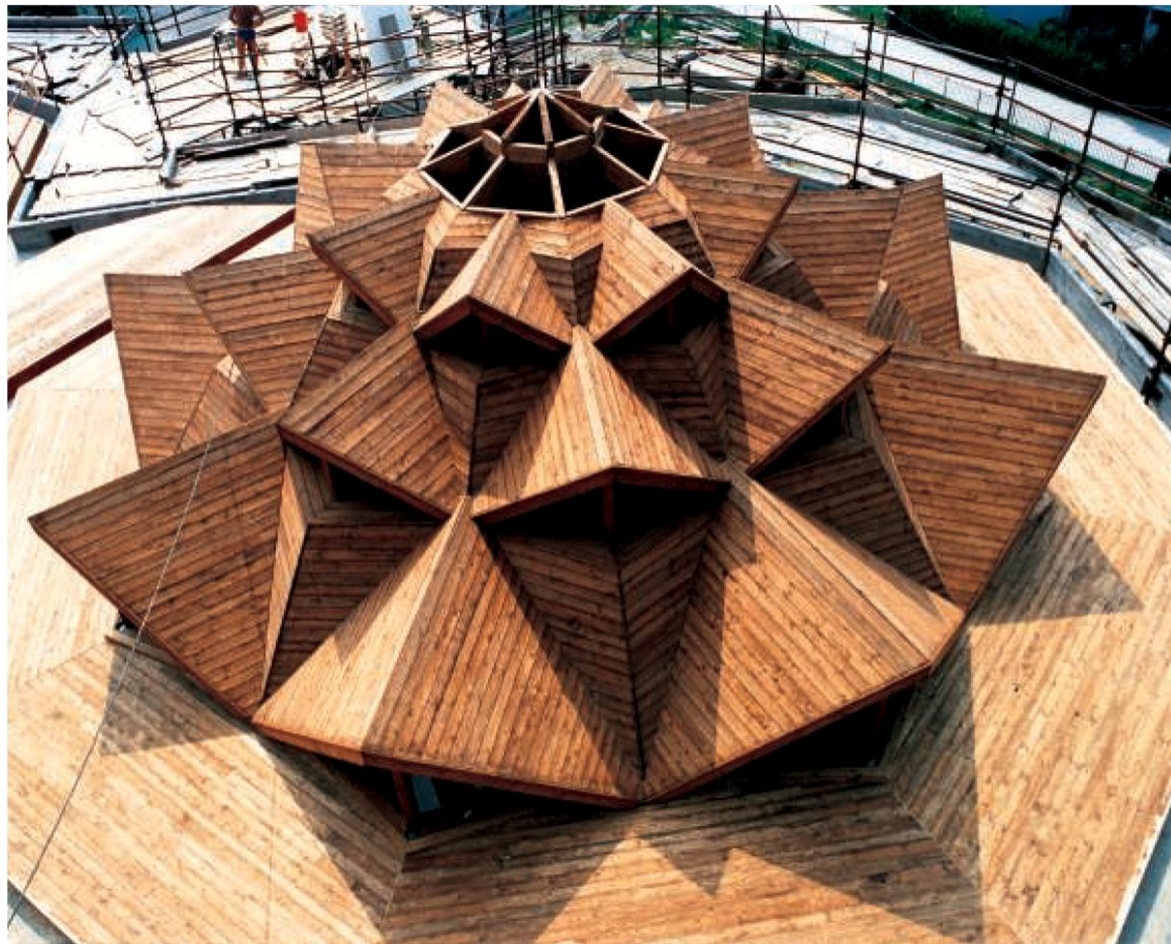
Giugno del 1990: le cupole vengono montate a terra.
