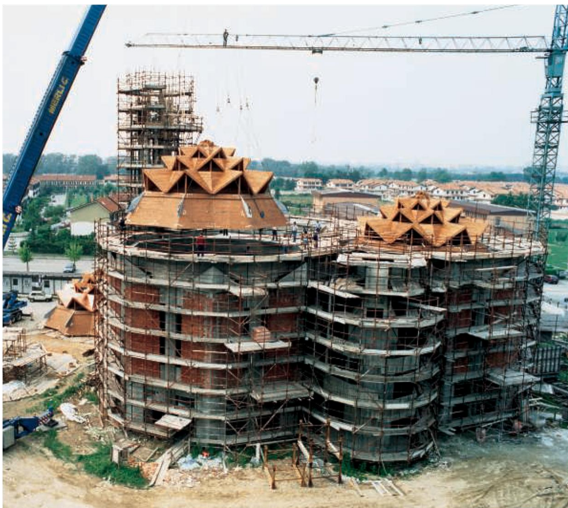
19 e 20 giugno 1990 – posizionamento delle cupole in legno
