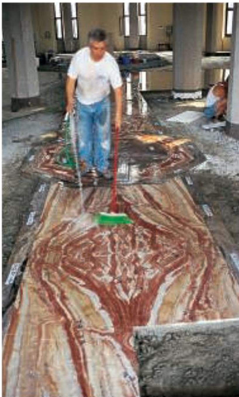
La posa del pavimento in marmo orobico arabescato
